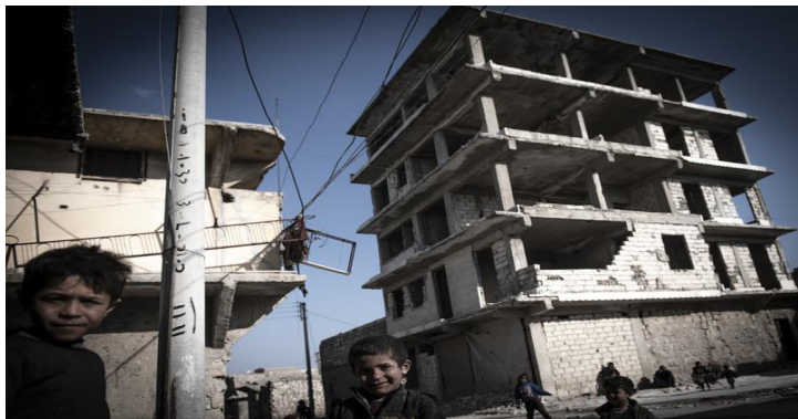
Niños árabes juegan debajo de un edificio al que se le cayeron las paredes por el terremoto del 6 de febrero. Aleppo, Siria. Mauricio Centurión / El Salto Diario
